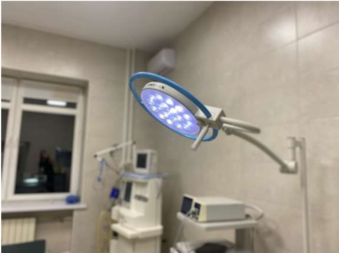
Рис. 2.9 Безтіньова лампа з рівнем освітленості 66000 люкс для освітлення операційного столу
